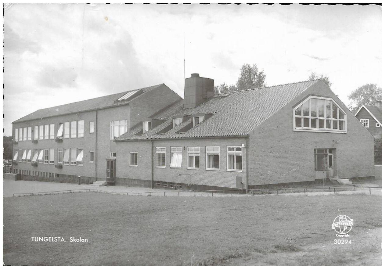
Tungelsta skola någon gång i början på 60-talet, när A-huset byggts till.
