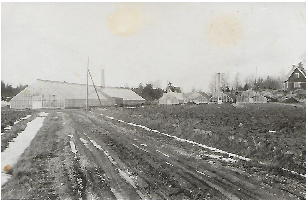
Bröderna Walls trädgård. Stamfastigheten finns kvar, men växthusen har ersatts med bostäder.
